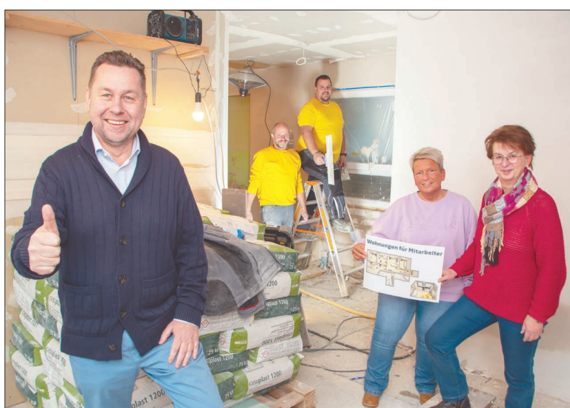
Geschäftsführer Michael Vetter (l.) besichtigt die umfangreichen Arbeiten bei der Sanierung der Wohnungen für Pflegefachkräfte mit Pflegedienstleiterin Stationäre Pflege Angela Scheil und Pflegedienstleiterin Ambulante Pflege Melanie Trautmann. Marco Müller und Sascha Siefert von der Haustechnik haben tatkräftig in einer Wohnung Verputzerarbeiten durchgeführt. Foto: Pflegezentrum Odenwald.
