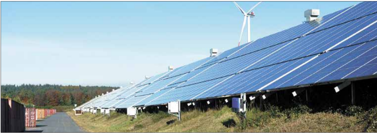
Zwischen elf Bunkerzwischenräumen wurden in den vergangenen Jahren rund 32.000 m³ Erdaushub verfüllt, um eine plane Dachfläche auf der Bunkerreihe zu schaffen. Die Dachfläche hat eine Breite von 18,75 Meter und eine Länge von 391 Meter. Die Hangfläche weist eine Höhe von 20,10 Meter auf und ebenfalls eine Länge von 391 Meter.
