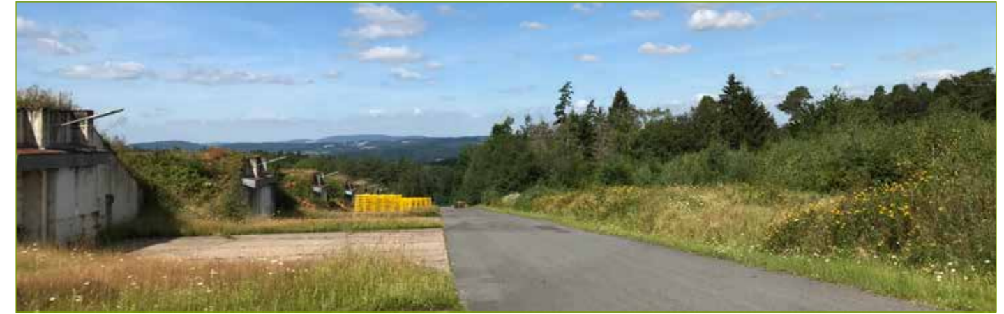
Teilansicht des südlichen-westlichen Areals
