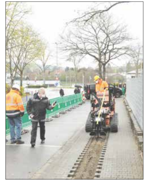
Vertikale Verlege Technik von Glasfaserleitungen mit der Grabenhexe der Fa. Klenk und Sohn GmbH (Modautal). Reduzierte Grabenbreite und schnelles Verlegen. 20 Meter in vier Minuten.
