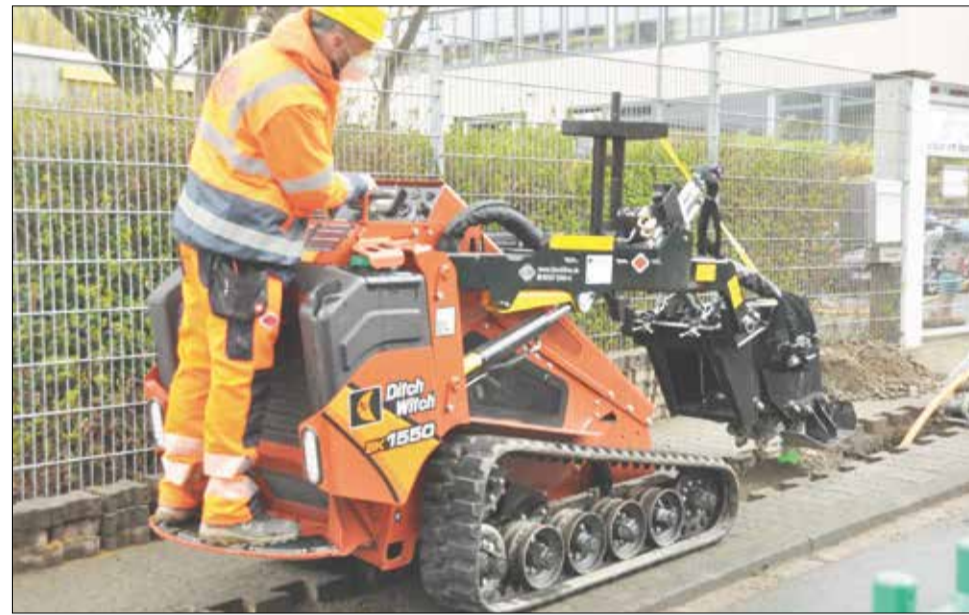
Vertikale Verlege Technik von Glasfaserleitungen mit der Grabenhexe der Fa. Klenk und Sohn GmbH (Modautal). Reduzierte Grabenbreite und schnelles Verlegen. 20 Meter in vier Minuten.
