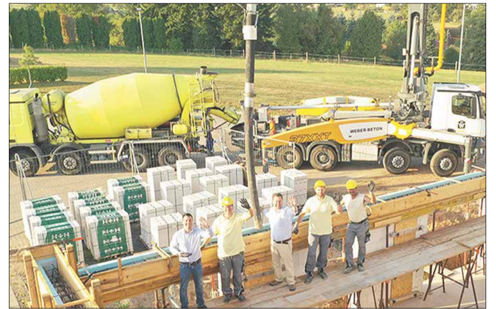
Tatkräftig wird im Team der Ringanker an der Arztpraxis und den neuen Räumen für die Mobile Pflege Oberzent betoniert. Unterstützt werden die Arbeiten wieder einmal durch ein Betonpumpenfahrzeug und einen Betonmischer der Bauunternehmung Weber aus Michelstadt. (v.l.n.r.: Philipp Vetter, Alexander Jäschke, Michael Vetter, Torben Meyer und Achim Uhrig).
