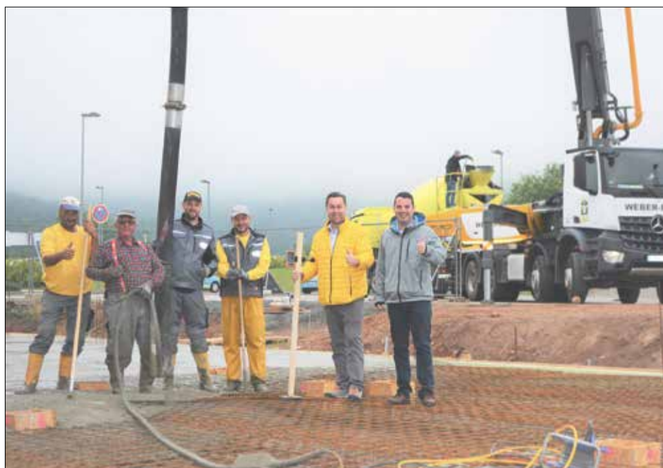
Der Pflegestiftung Odenwald als Bauherr der allmehrzweckigen Hausärztlichen Gemeinschaftspraxis und der Räumlichkeiten für die Mobile Pflege Oberzent in der Seniorenresidenz Hedwig Henneböhl ist es wichtig, daß örtliche Unternehmen an dem Projekt beteiligt sind. V.l.n.r.: Maurer Achim Uhrig, Bauhelfer Eugeniusz Rynowicki, Elektriker Torben Meyer, Maler- und Lackierer Marco Müller, Geschäftsführer Michael Vetter (Pflegestiftung Odenwald) und Geschäftsführer Philipp Vetter (Pflegeservice Odenwald GmbH).
