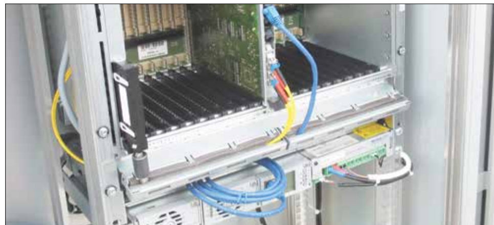
Das Breitbandnetz Odenwaldkreis ist die Grundlage für die Digitalisierung der Region. Bild: R. Kaffenberger
