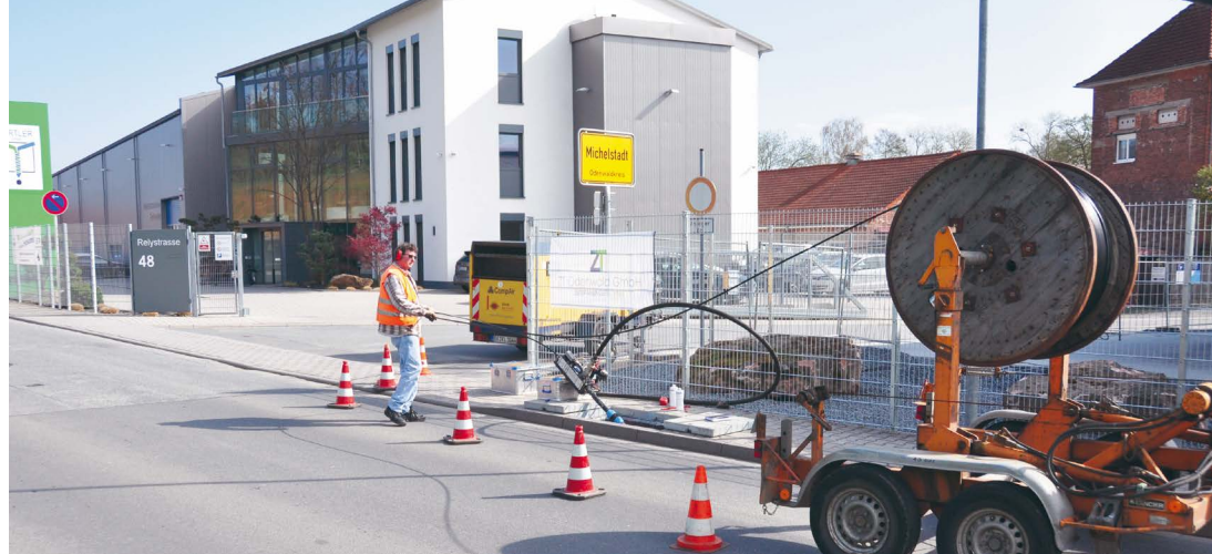
Verlegung eines Hightech-Glasfaser-Netzanschlusses in Michelstadt.
